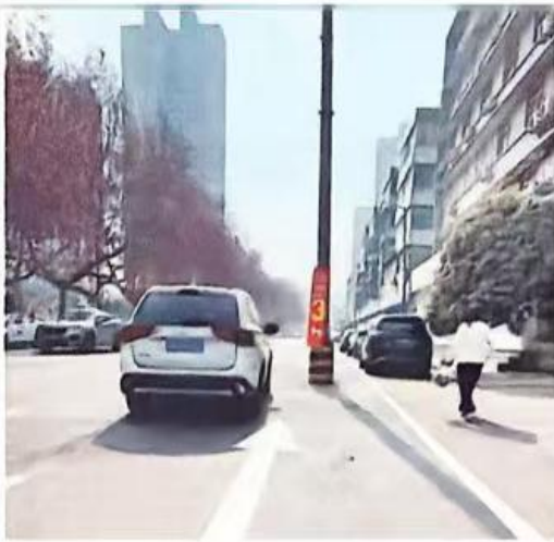
电线杆立在车道中央，市民担心有安全隐患。
